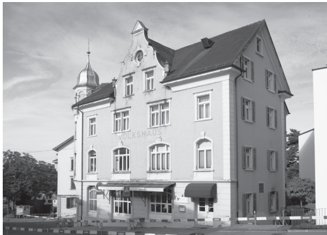
«Das Parteilokal der SP Wädenswil befindet sich im Obergeschoss vom Volkshaus.»
