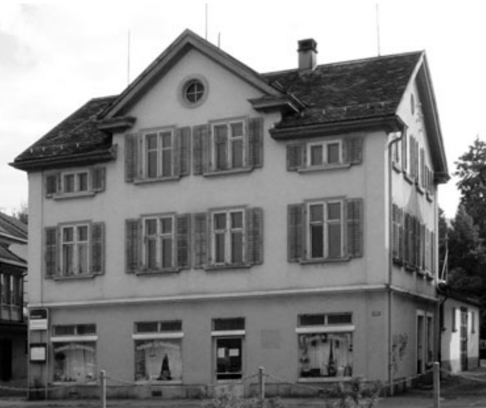
Die Seestrasse 135 beherbergt hoffentlich bald das neue Ortsmuseum
