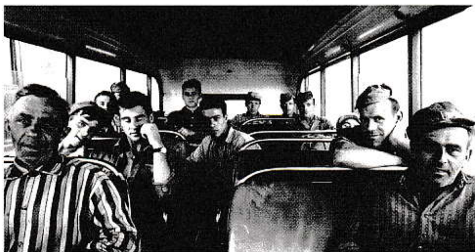
Fahrt zur Baustelle; Autobahnbau Wädenswil
